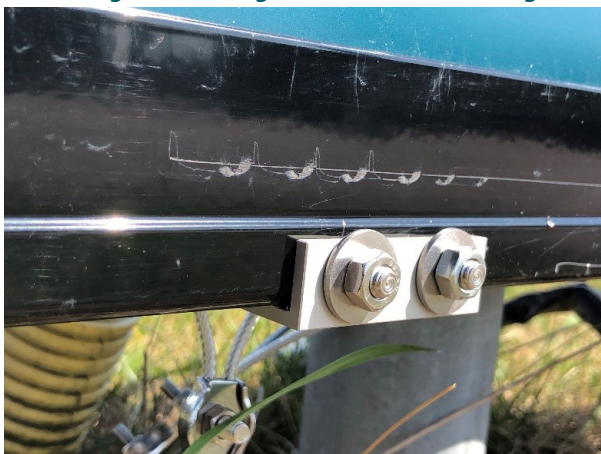
Abbildung 19: Unterlegscheiben und Sicherungsmuttern montieren
