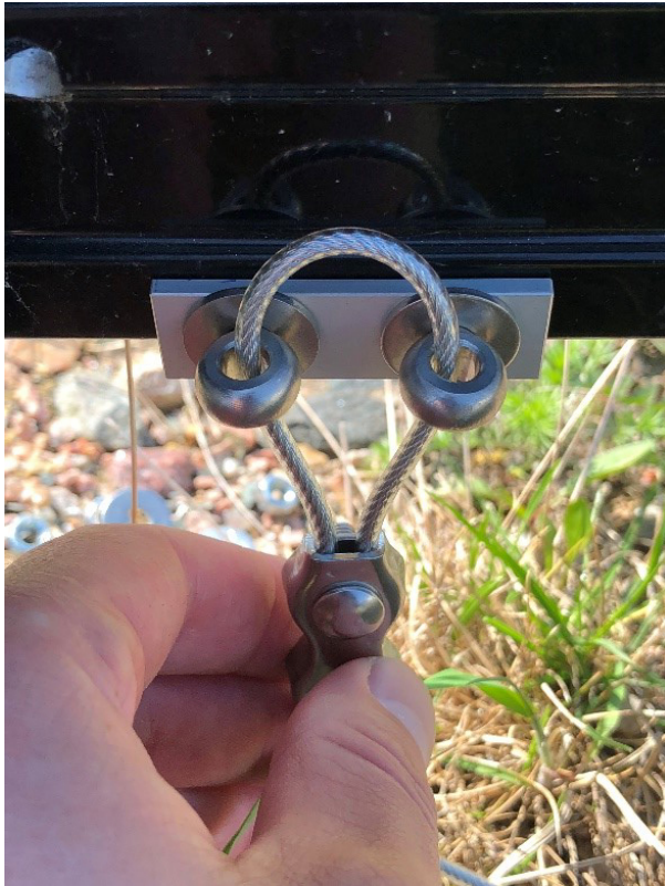
Abbildung 18: Unterlegscheiben und Augenschrauben einsetzen
