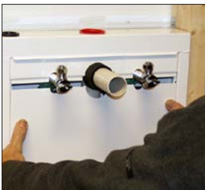
Nedre sprutplate slippes ned i skapet for så å løftes opp på fals i øvre plate. Sjekk gjennomføring.
