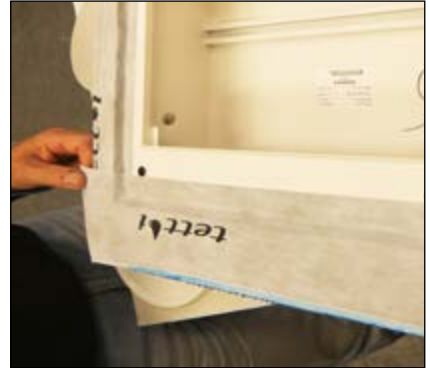
Fjern butylbåndet som evt blir liggende over pop-mutteren på 4x4 skapet for å sikre en god vedheft.
