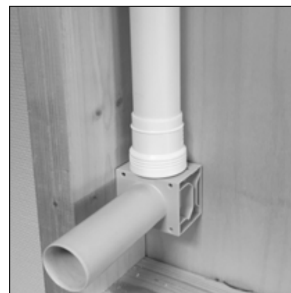
Avløpsbendet monteres ut av vegg med siklemikk.
