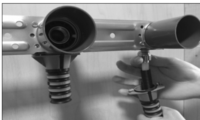
Skru fast kuplingen på veggboksen, trekk til kuplingen med momentnøkkelen. Riktig moment indikeres ved at momentnøkkel klikker. (PS: Kun et klikk)
