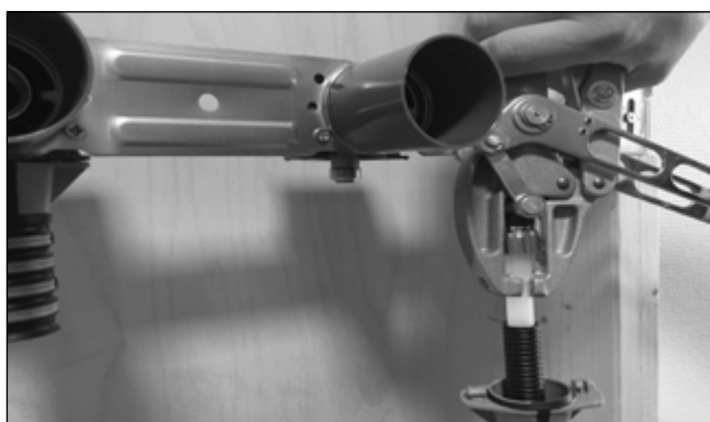
Monter kuplingen ved hjelp av montasjetangen. (Pass på at røret er kuttet rett)
