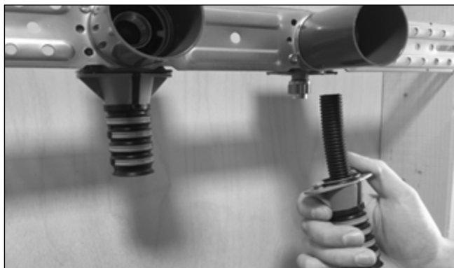
Tre rør og varerør gjennom boksfoten.
