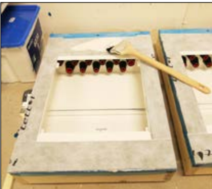
Påfør påstrykningsmembranen iht. membransystemets brukerveiledning.
