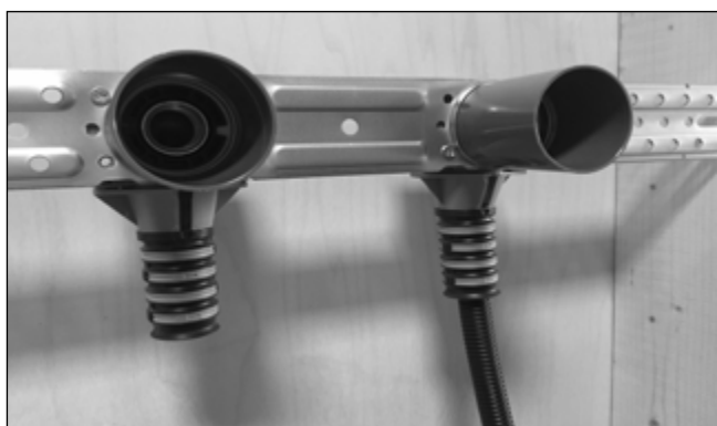
Monter boksfoten. PS: Skru alltid boksfoten av/på ved hjelp av "plastvingene" på toppen av boksfoten.
