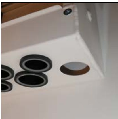
Erstatt gjennomføring med drensklips.
