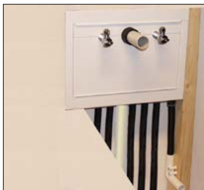
Rett monterert skal fronten flukte med ferdig vegg.
