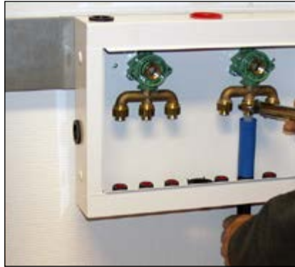
Entre kpling for hånd og trekk til med momentnøkkel.
