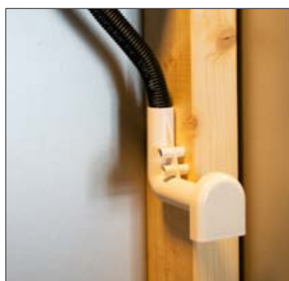
Avløpsbendet monteres ut av vegg med siklemikk.
