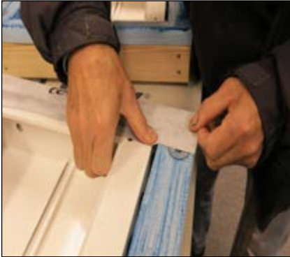
Påse at butylbåndet bearbejdes og strykes godt til underlaget.
