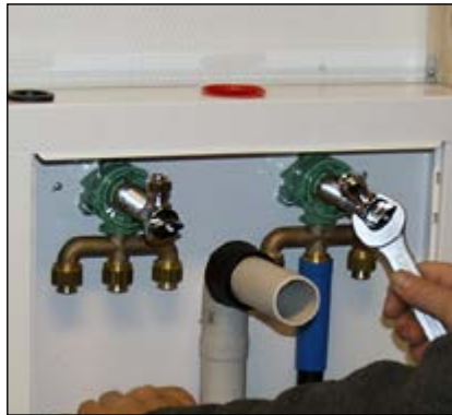
Tilpass og monterer vinkelventiler i veggbokser. Plugg ubenyttede uttak.
