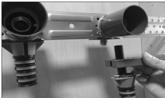
Trykk ned veggboksens underdel over røret og kapp ytterrøret 5 cm. Målet får du ved hjelp av rørkutterens bakside.
