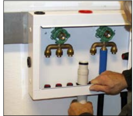
Klærgjør og koble til rør for vannkurser og avløp. Plugg ubenyttede uttak.
