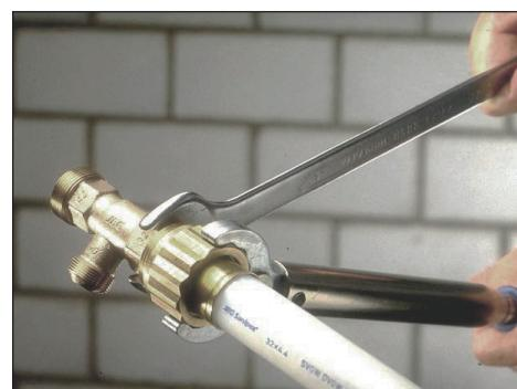
6.Monter så røret med kuplingen på rørdelen og stram til du hører klikket i momentnøkkelen.
