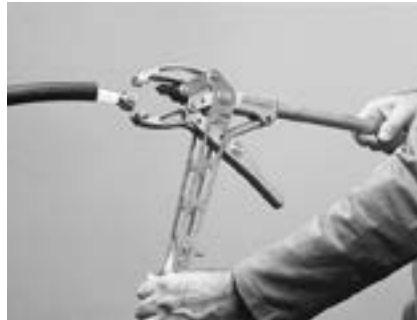
5. Åpne montasjetangen. Røret med kuplingen frigjøres automatisk og er ferdig til å monteres på fordeler eller veggboкс.
