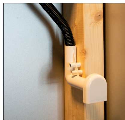
Avløpsbendet monteres ut av vegg med siklemikk.
