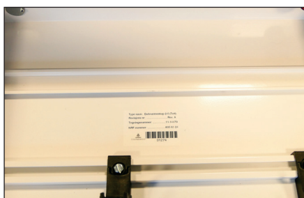
Øverste skinne i skapet er DIN-skinne til kontrollboks.
