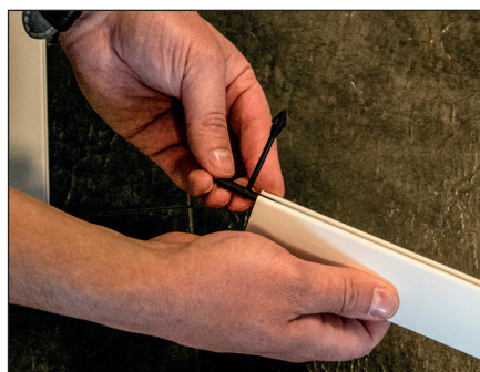
Plasthengsler benyttes ved behov, disse tres inn i den nederste profilen.
