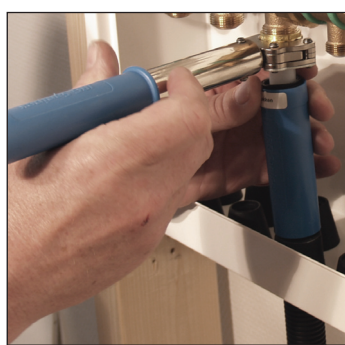
Demonter det defekte røret fra fordeler og fjernkoplignen.
