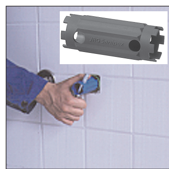
Demonter blandebatteri/kran. Skru ut festering eller boksforlenger i veggboxen ved hjelp av monteringsnøkkel, NRF nr 511 28 18.
