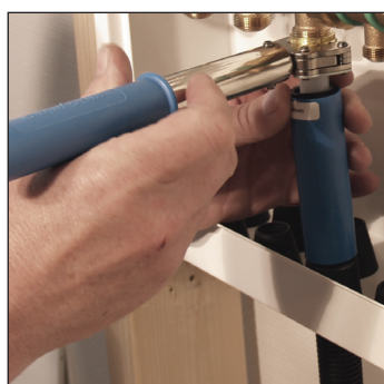
Koble røret til fordeler med momentnøkkel, NRF nr 511 28 xx.
