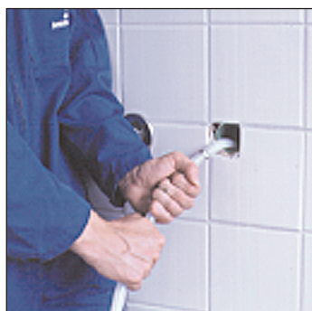
Trekk det defekte røret ut (gjennom veggboxen) samtidig med at det nye røret (som er koblet til det gamle) skyves inn.
