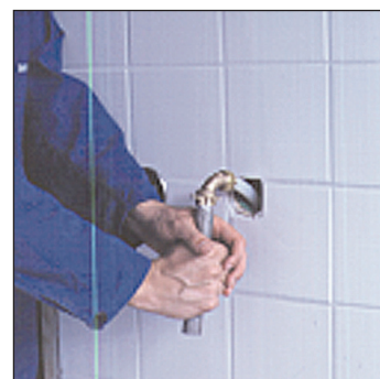
Monter deretter albue i veggboxen og skru inn festering eller boksforlenger.
