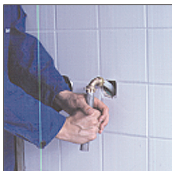
Skru monteringsrør, NRF nr 511 28 22 på albuen og trekk dette ut av boksen, ved å trekke og løfte i en bevegelse.
